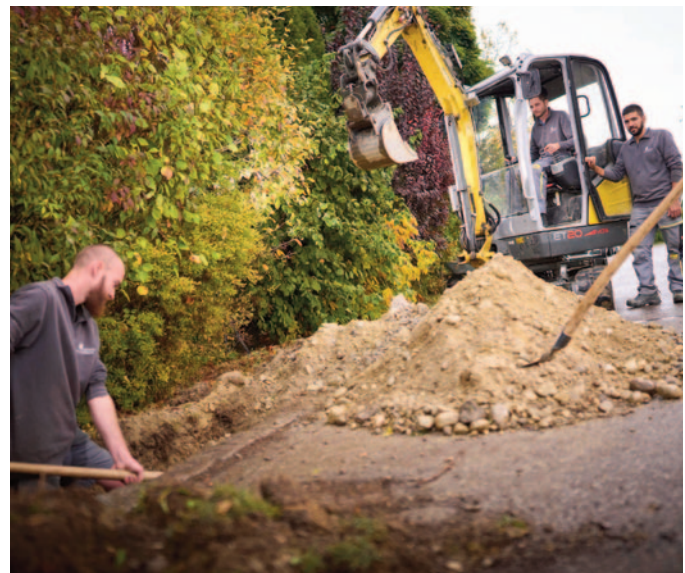
Bild: © Stadtwerke Fürstenfeldbruck: Viele Kilometer neue Wärmeleitungen müssen verlegt werden
